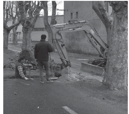
Travaux de tranchée entre platanes
